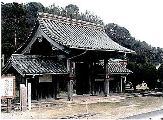
国分寺の門 文化4年（1807）客館の新築と同時に建立された。
