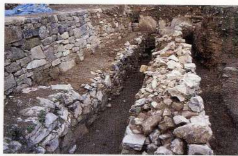
排水路(正面奥が閉じている)
